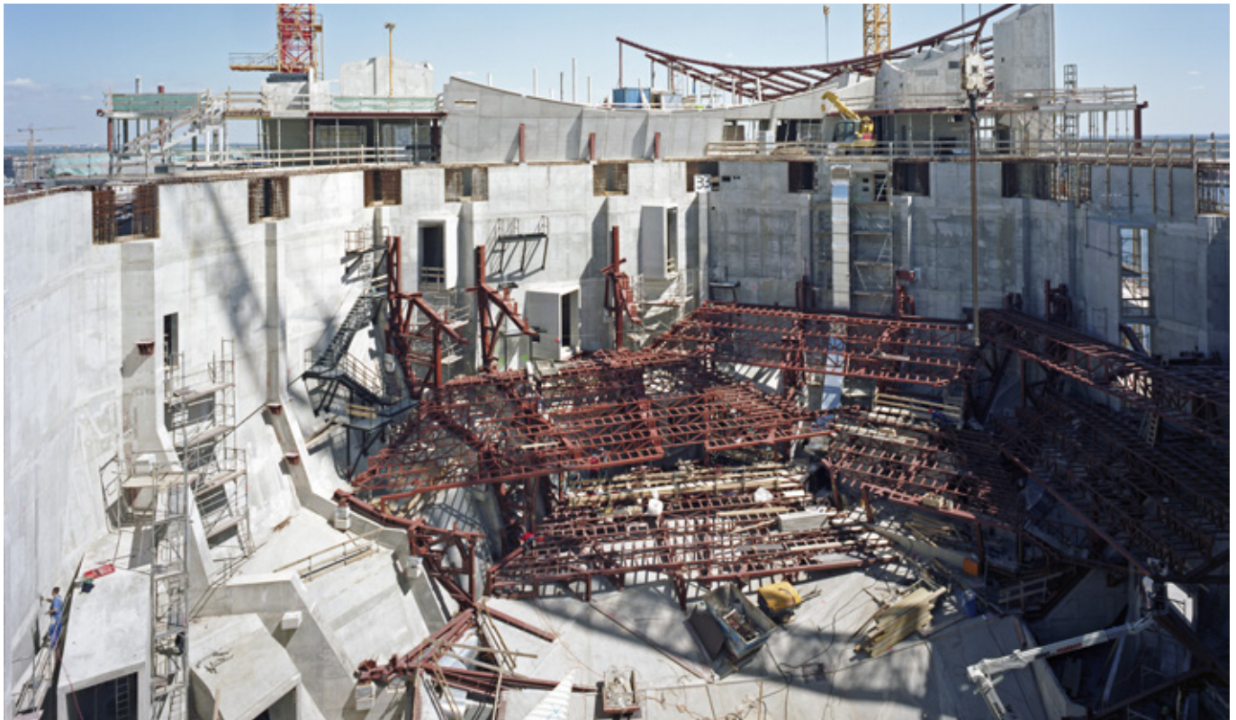
Bild 1: Blick in den Konzertsaal der Elbphilharmonie Hamburg im Bauzustand. Foto: Elbphilharmonie Hamburg / Oliver Heissner
